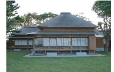
客間棟(左奥:居間棟)
