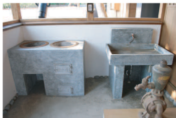
水屋 人造石研ぎ出し仕上の ヘツツイ・立ち流し (手前は大正時代の井戸ポンプ)
