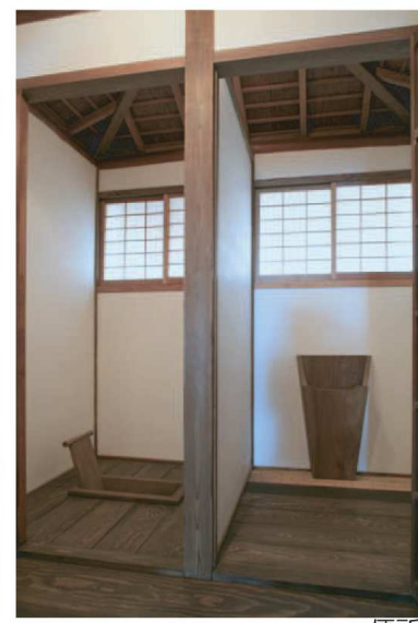
便所 木製大便器・小便器
