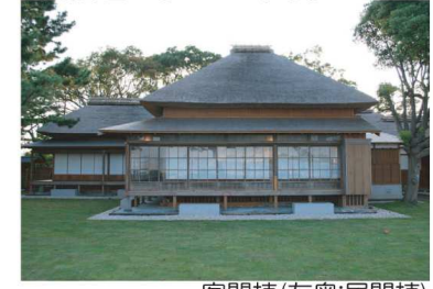
客間棟(左奥)居間棟
